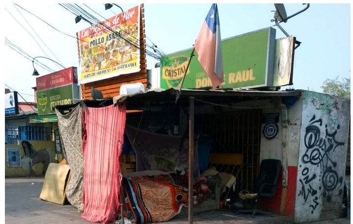
Al lo largo de Chile existe un gran número de viviendas improvisadas y de construcción precaria.
