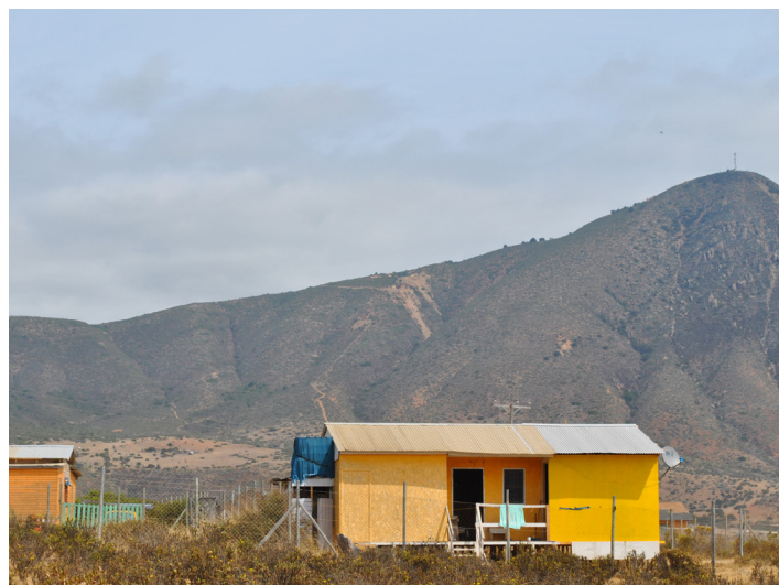
Casa sin sistema de red agua, abastecida a través de camiones aljibe.
